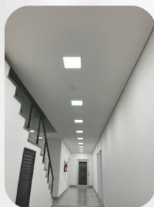
Forro em Drywall
